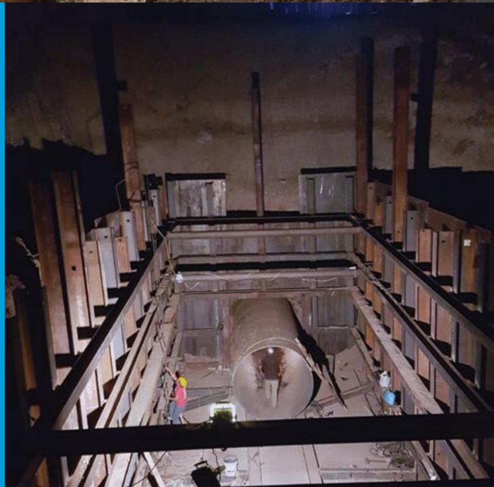
PROCEDIMIENTO CONSTRUCTIVO PARA HINCADO DE CAMISAS Y CONSTRUCCIÓN DE LUMBRERAS EN DIFERENTES OBRAS.
