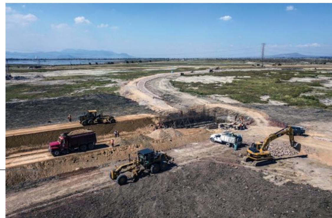
CONSTRUCCIÓN DE CANAL DE DESCARGA A DREN CHIMALHUACÁN II, REVESTIDO CON CONCRETO ARMADO, TEXCOCO, EDO. DE MÉXICO.
